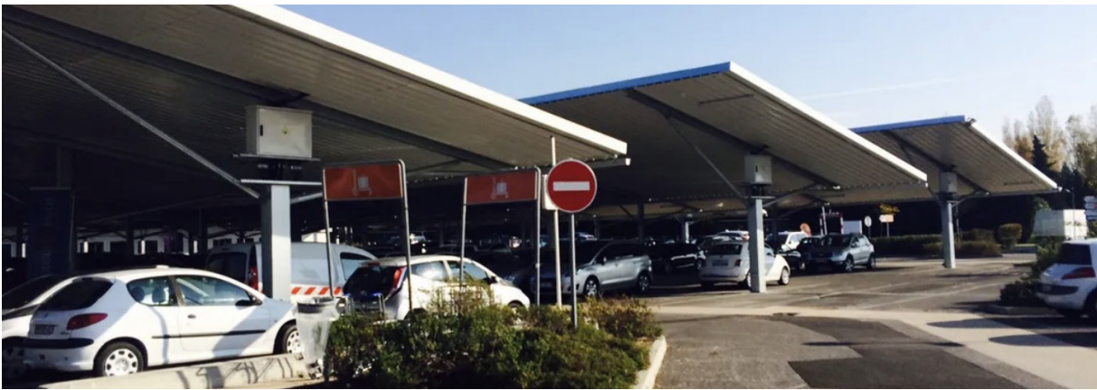
Ombrières photovoltaïques | Vue depuis les véhicules couverts
