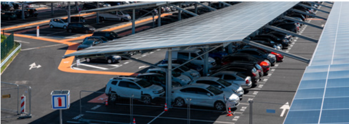
Ombrières photovoltaïques | Vue aérienne
