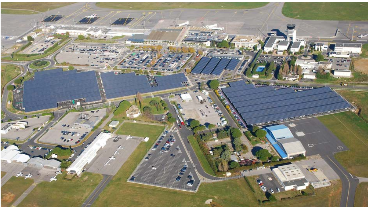
Ombrières photovoltaïques | Vue aérienne de l’aéroport
